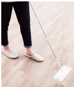
雑巾やモップなどで、施工する床面をキレイに清掃してください。貼る前に、仮置きして位置を確認(割付け)してください。
