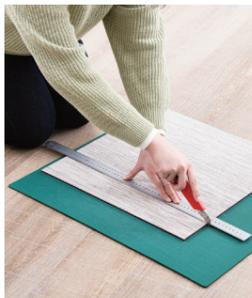
割付け後、部屋の形に合わせてカットします。
